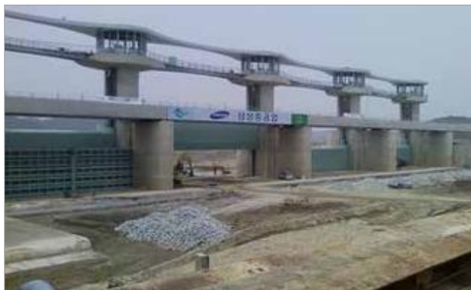
Positionsmessung von Schleusentoren
